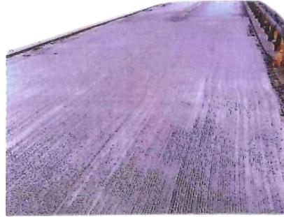
Tanda potongan dari conical bit
